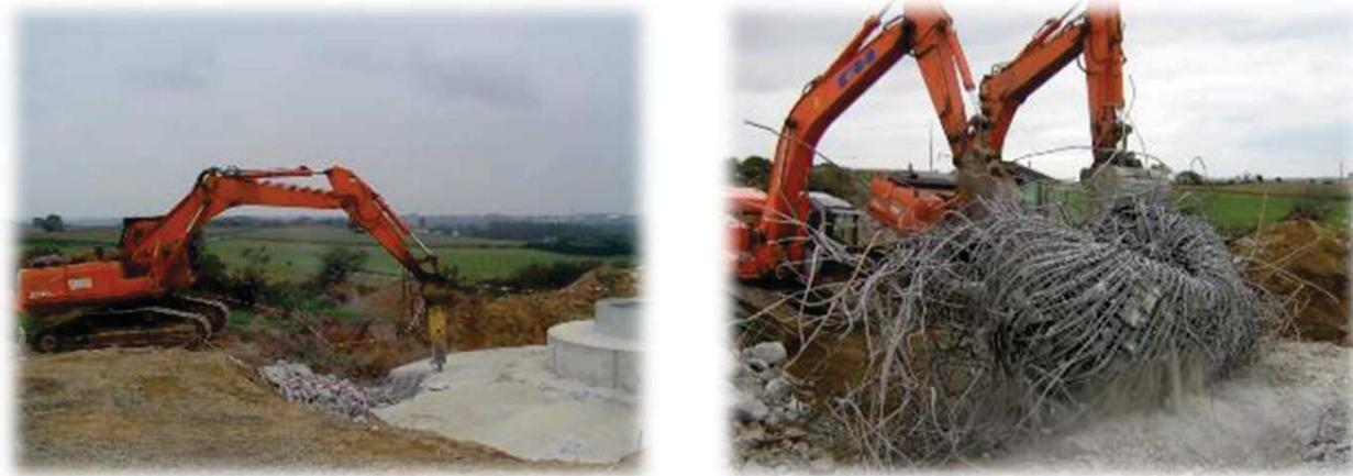
Illustration 36 : éclatement des fondations (à gauche) et enlèvement du ferrailage (à droite)
