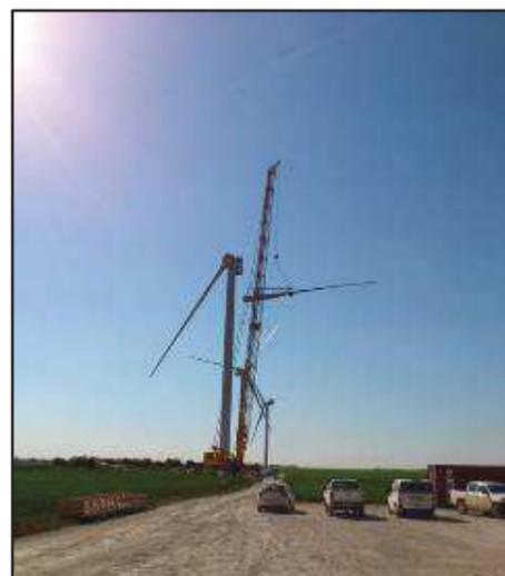
Illustration 31 : montage des éléments du mat (à gauche) et du rotor « pale par pale » (à droite)
