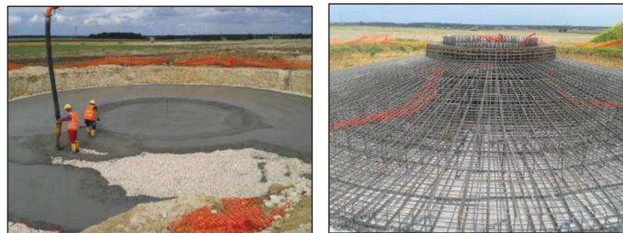
Illustration 28 : coulage du béton de propreté (à gauche) et ferrailage du massif de fondation (à droite)
